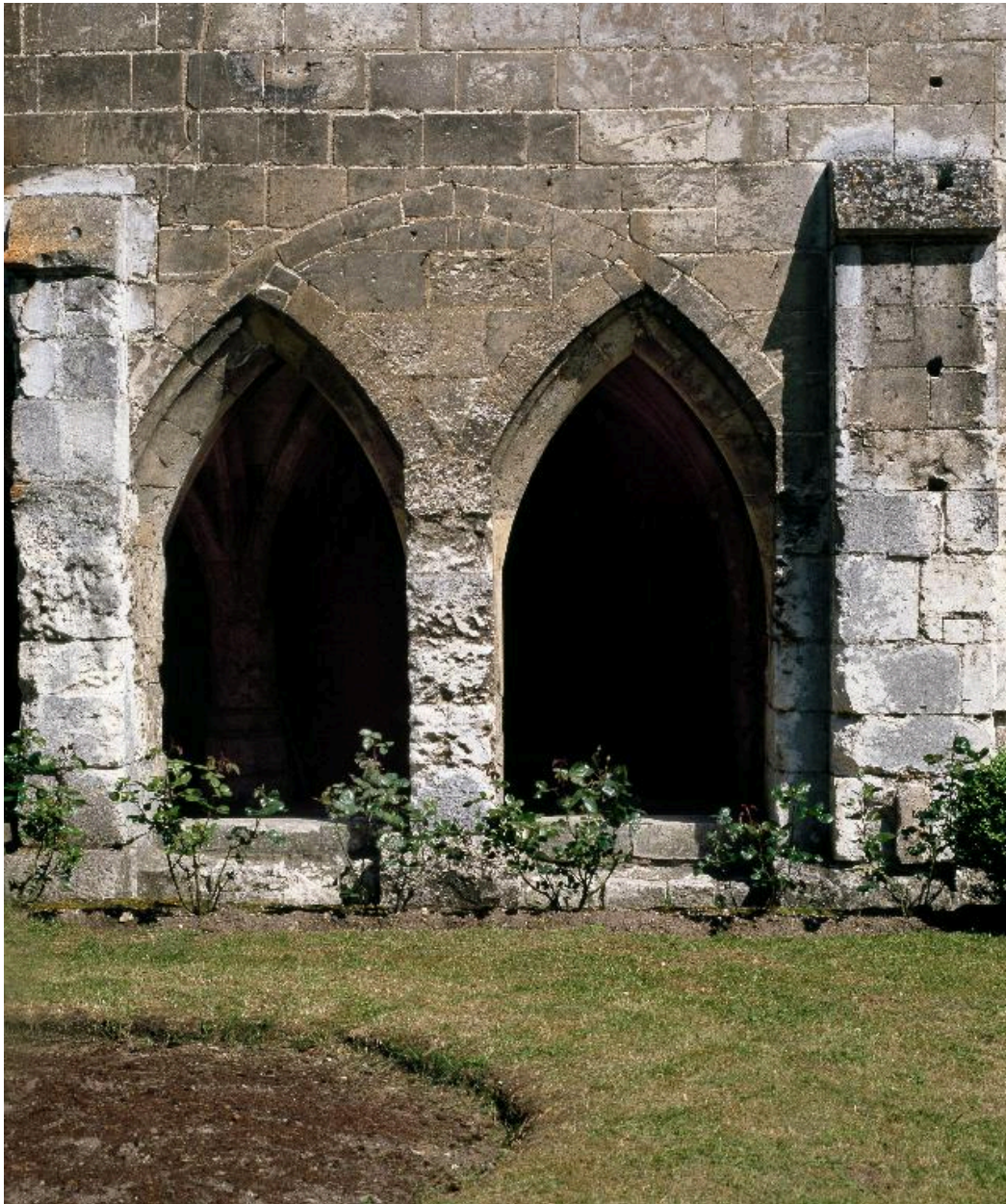
Vue des arcades sous la salle capitulaire.
