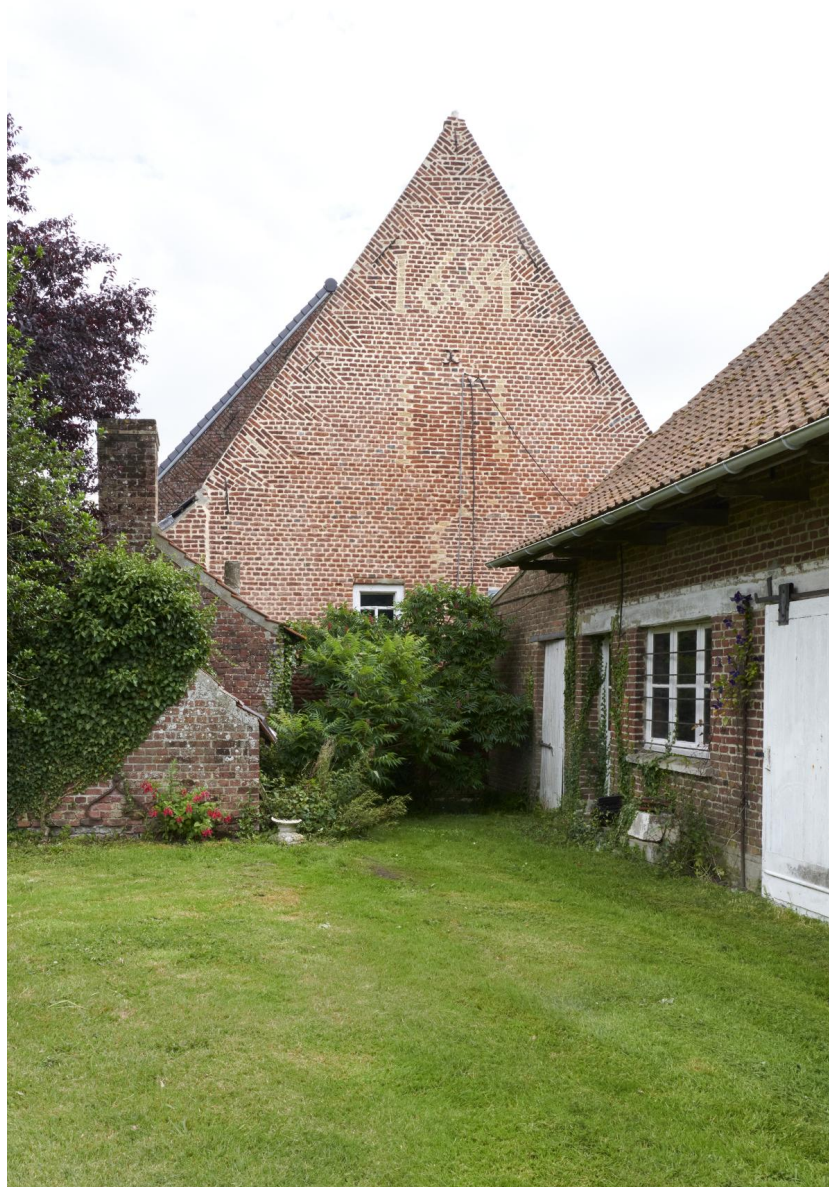
Pignon sud-ouest du logis avec date portée de 1664 et annexe au premier plan.
