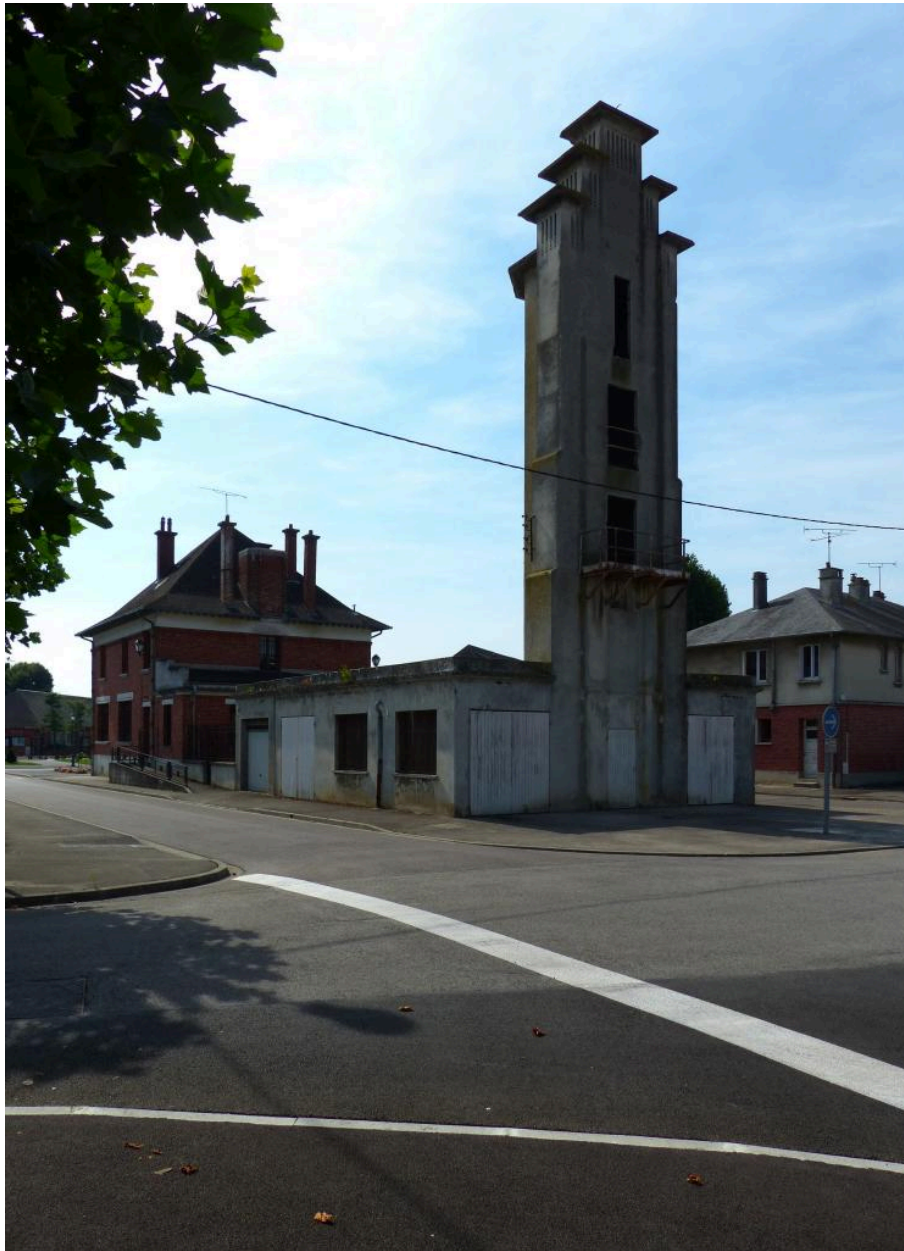
Vue de la remise et de la tour, depuis le nord.
