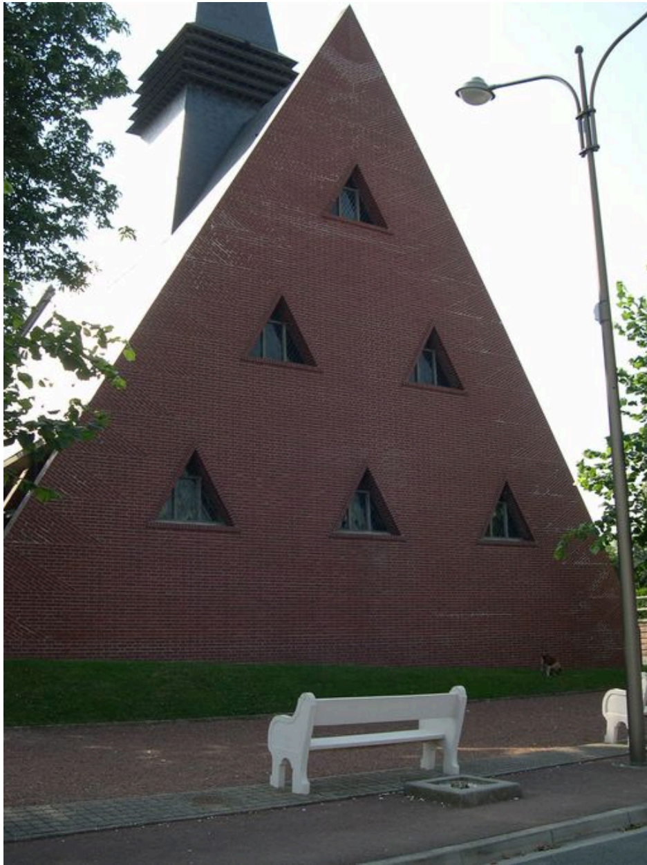
Vue du pignon oriental.
