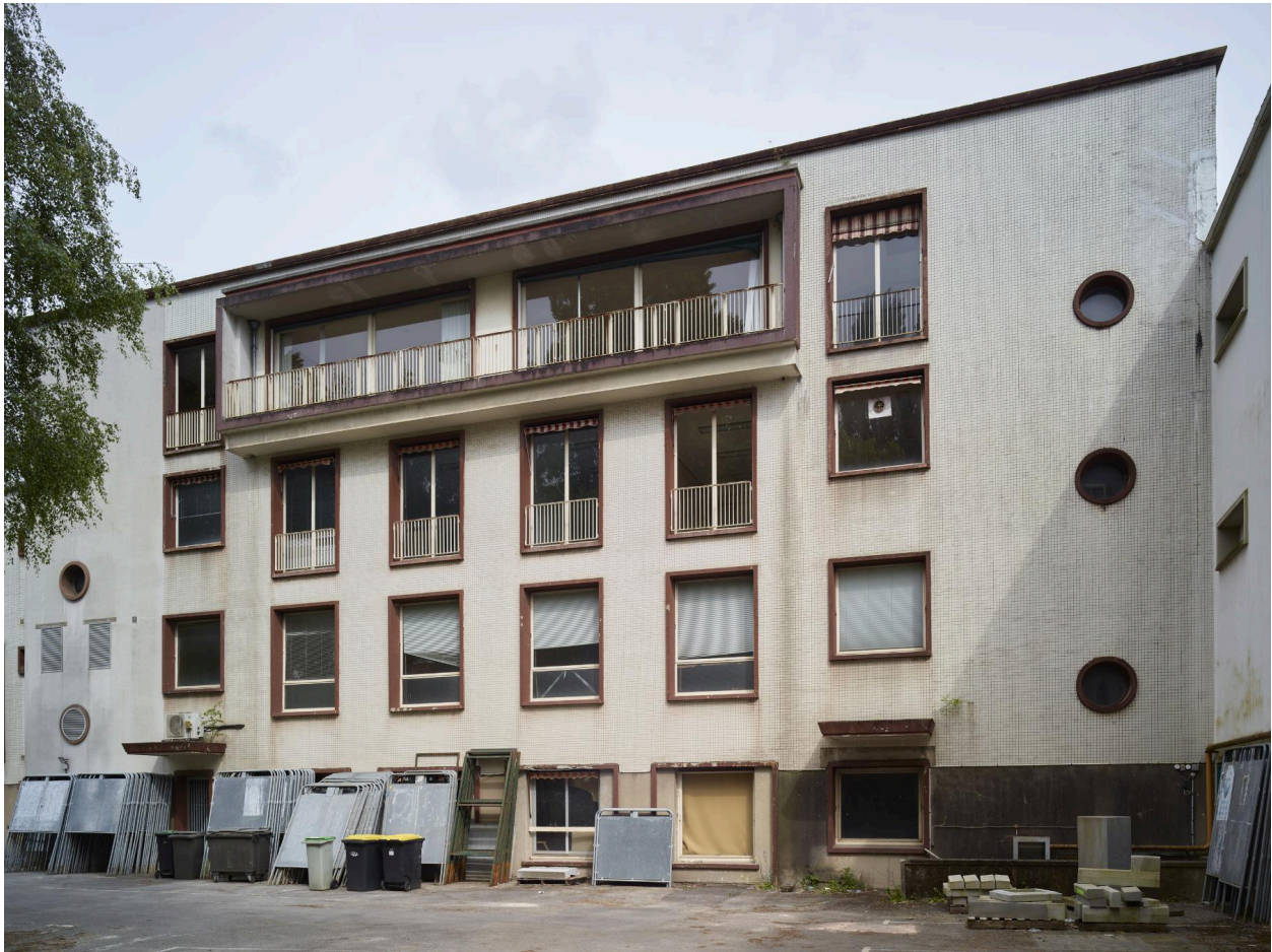
Vue de l'élévation ouest depuis la cour intérieure.
