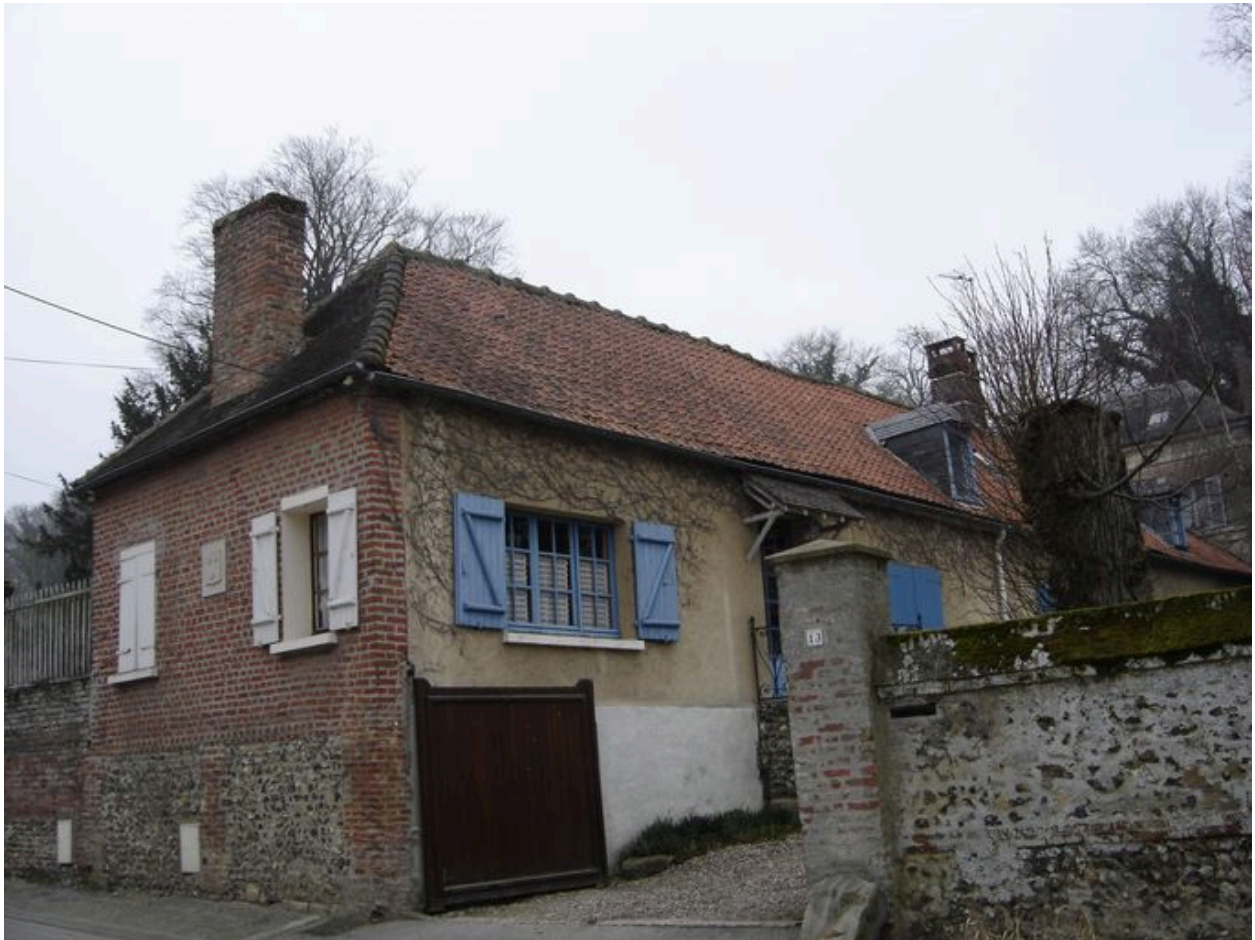
Vue des dépendances du nord depuis la rue.
