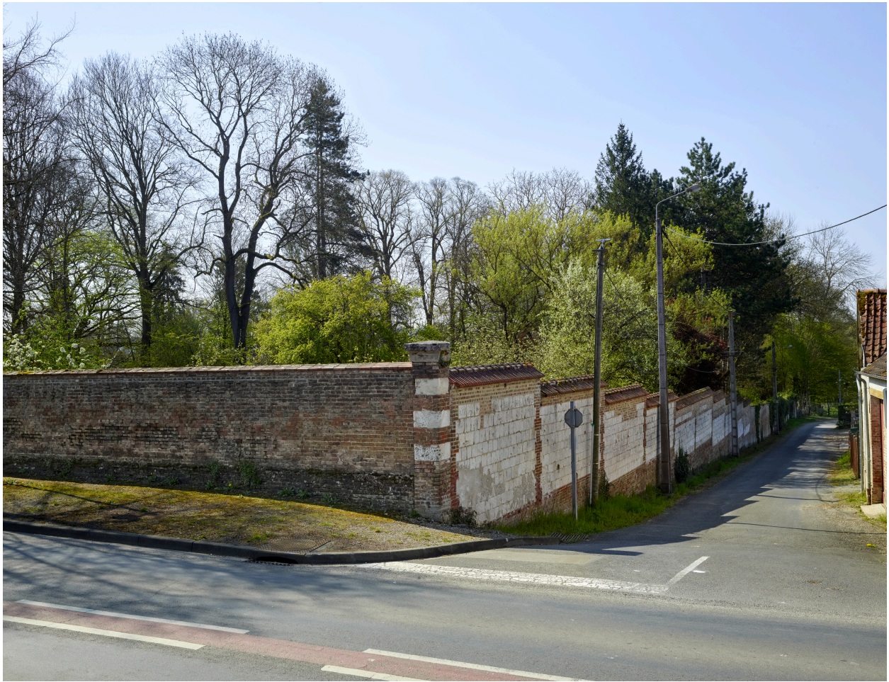
Mur de clôture du parc ente la route de Paris et l'impasse du Hamel, depuis le nord.
