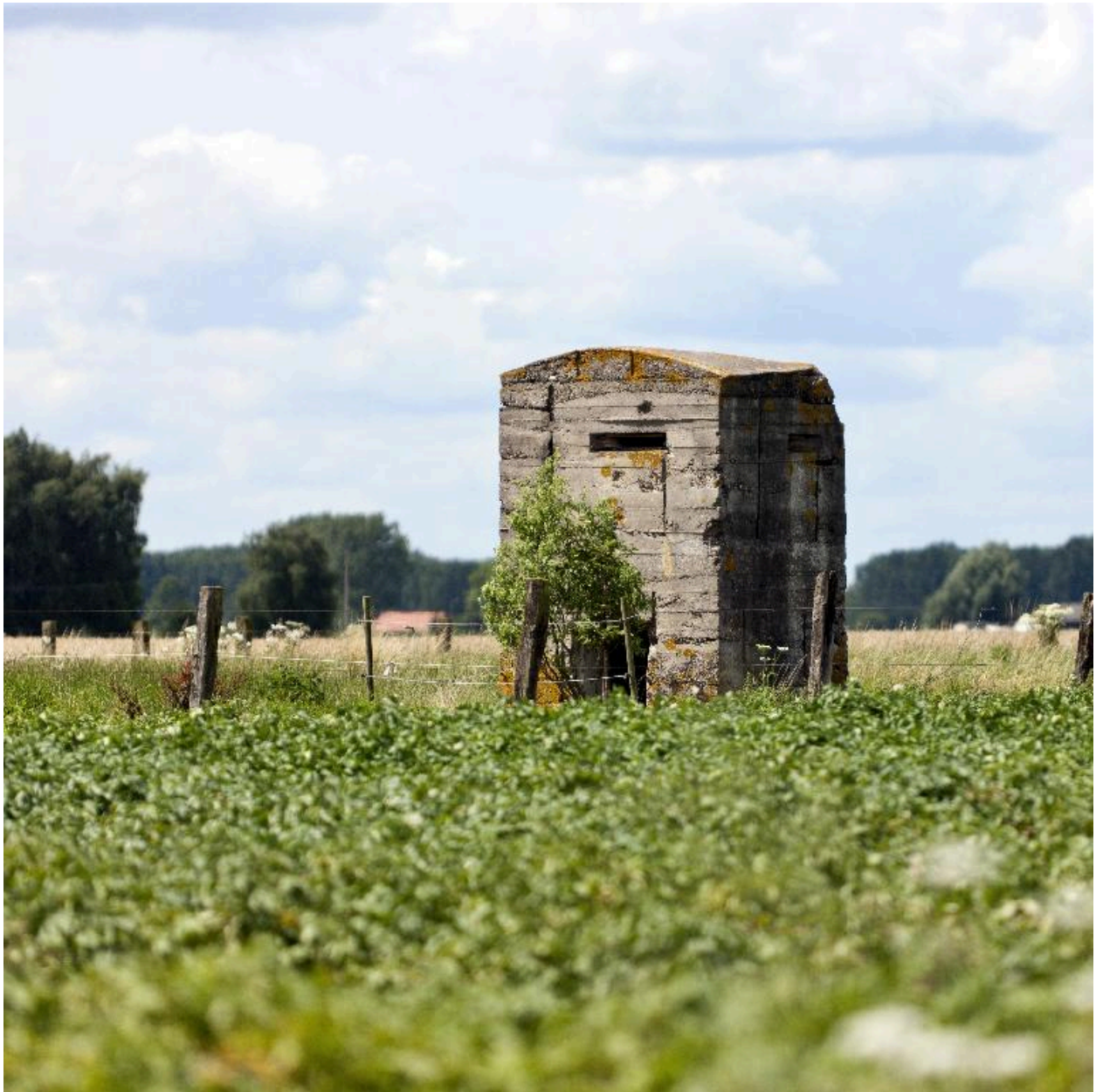
Vue générale vers le nord-ouest
