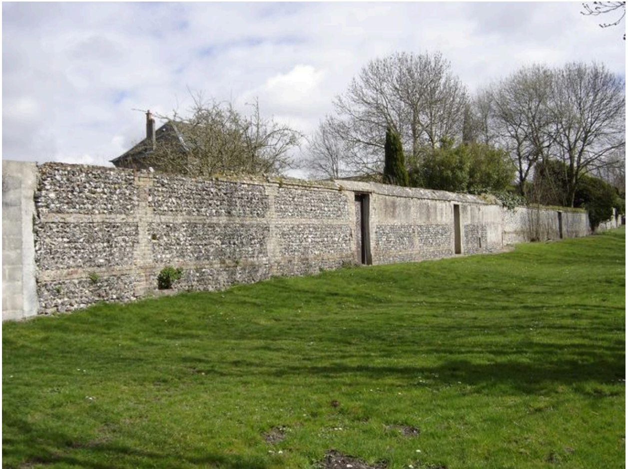
Vue du mur de clôture longeant la rue du Riot.
