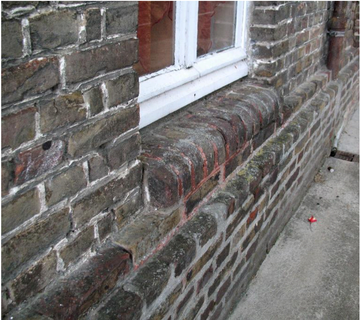
Détail d'un appui de fenêtre.
