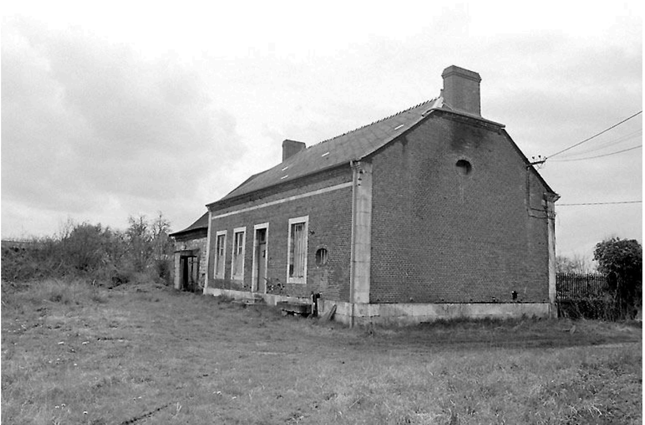
Elévation postérieure du logis construit au milieu du 19e siècle.
