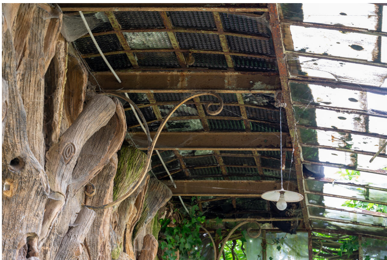
Détail des consoles de support de la verrière du jardin d'hiver.
