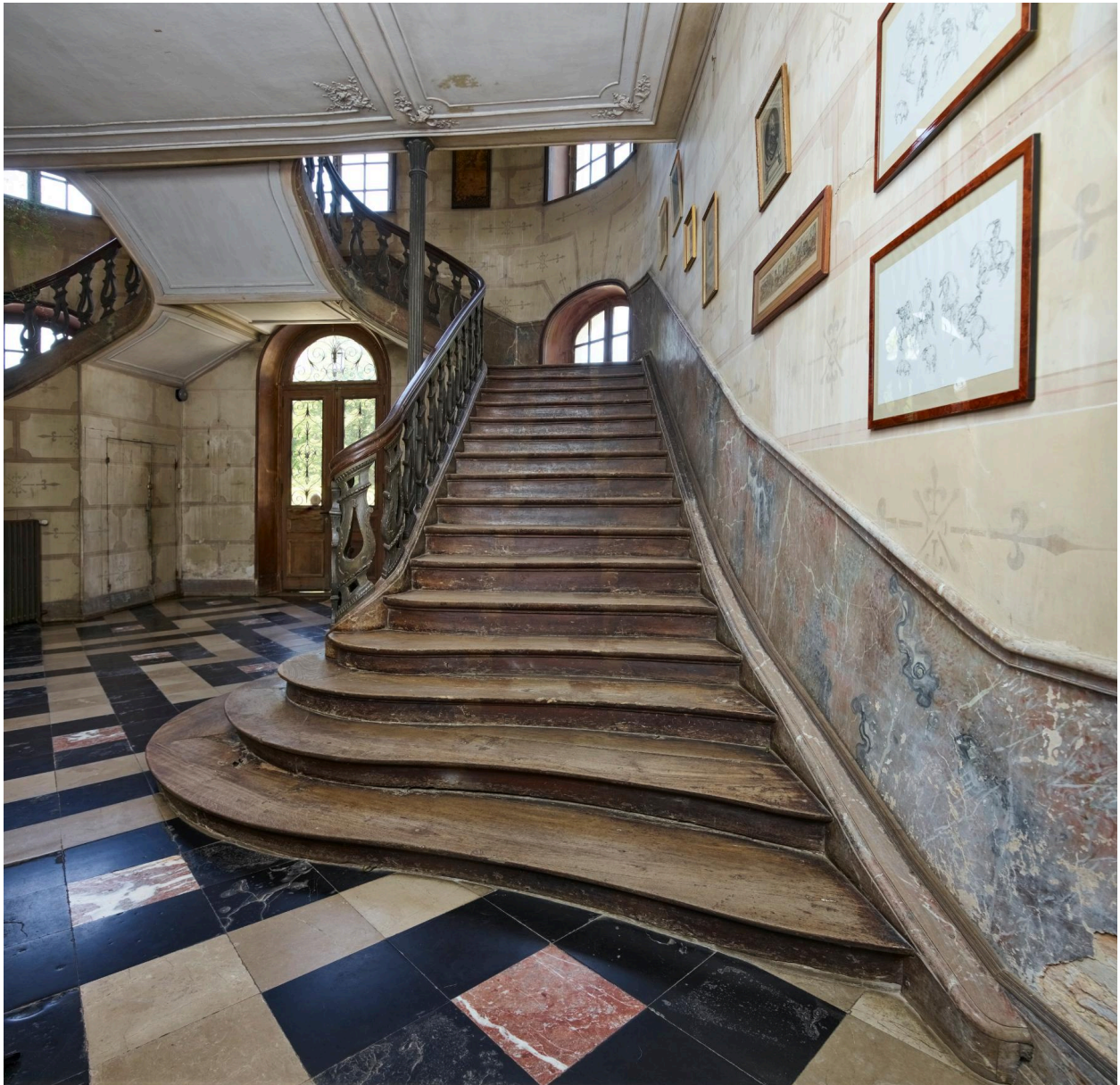
Volée de l'escalier à double volée du vestibule, vue de face.
