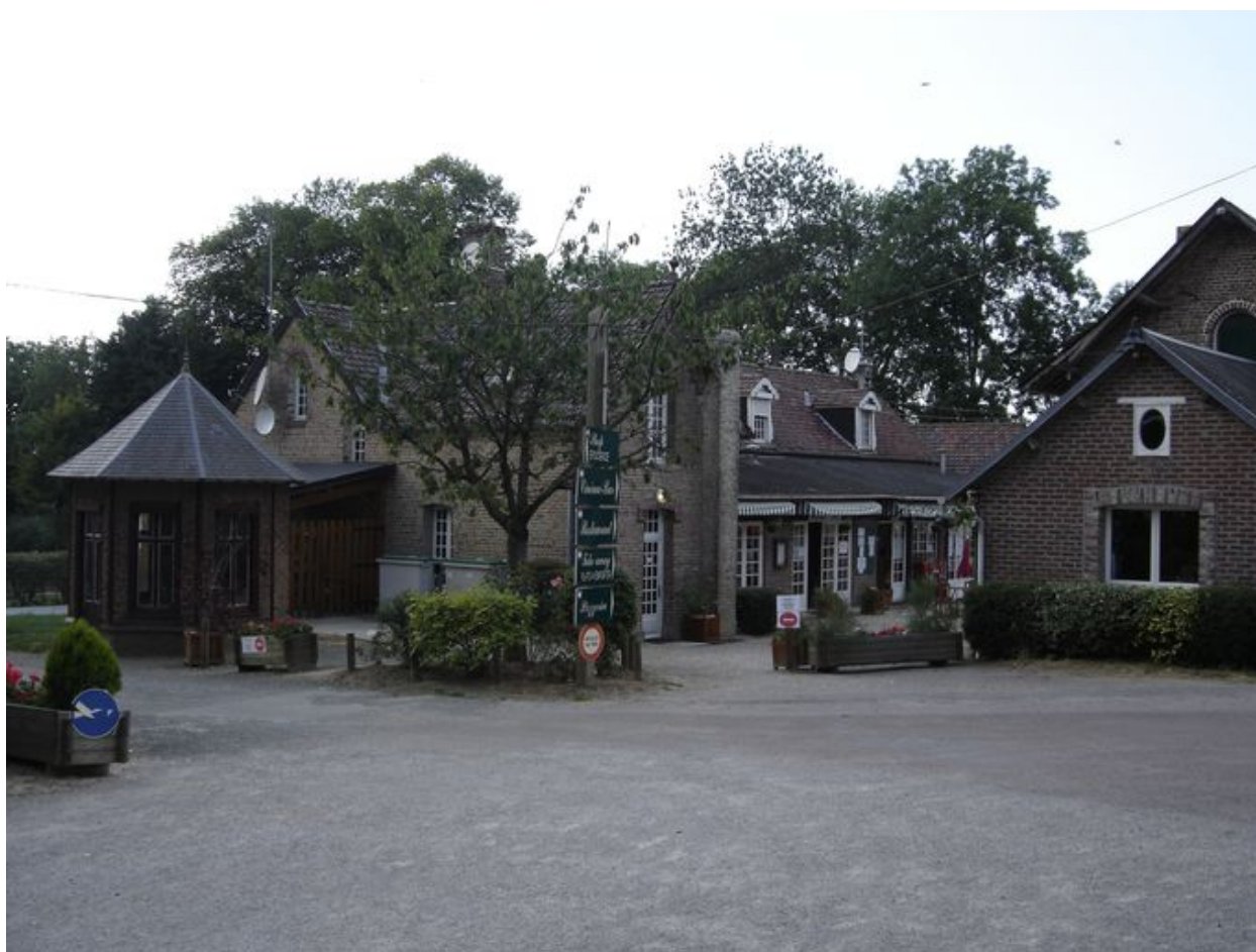
Vue générale des bâtiments agricoles .
