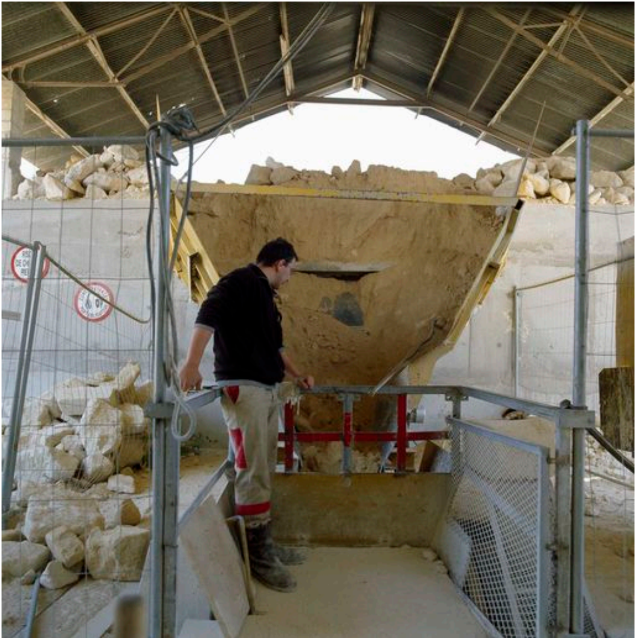
Concassage des blocs pour la préparation du craon (carrière Ouachée-Corpechot, Saint-Maximin).
