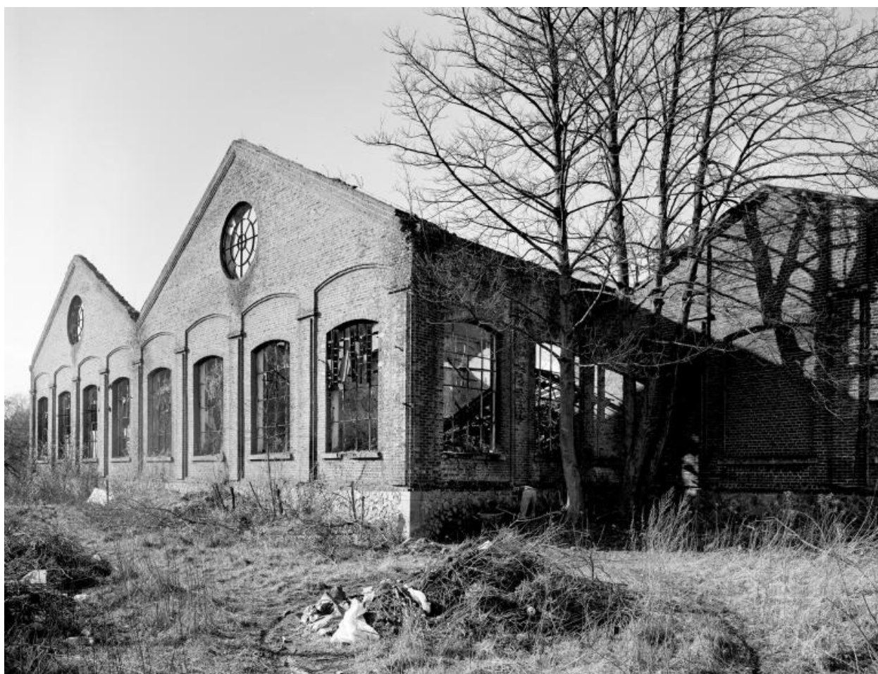
Sous-station électrique. Élévation sur la Sambre.
