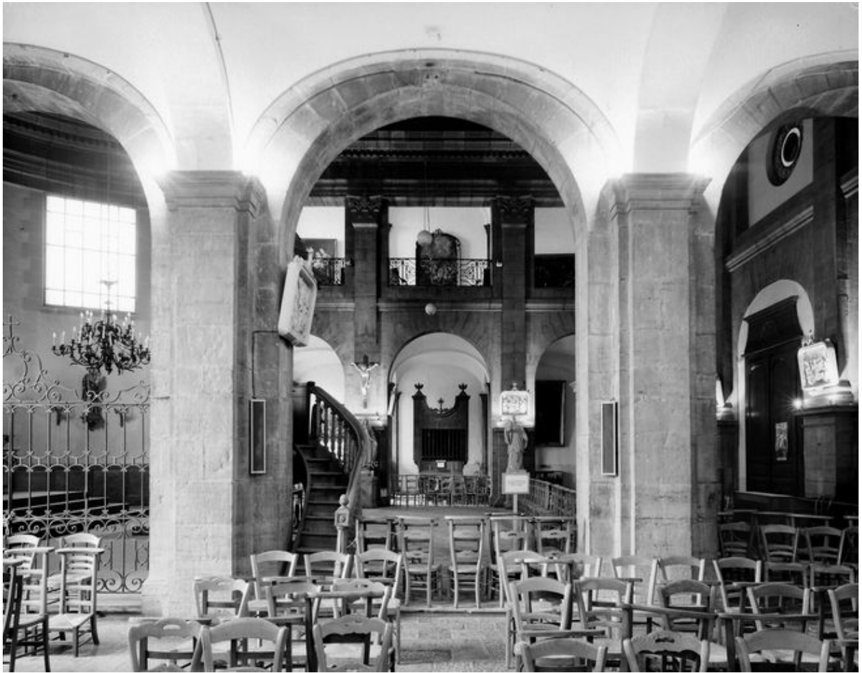
Corps de bâtiment fermant le fond de la cour d'honneur, rez-de-chaussée, chapelle, vue prise depuis le bas-côté nord en regardant vers le vaisseau central.
