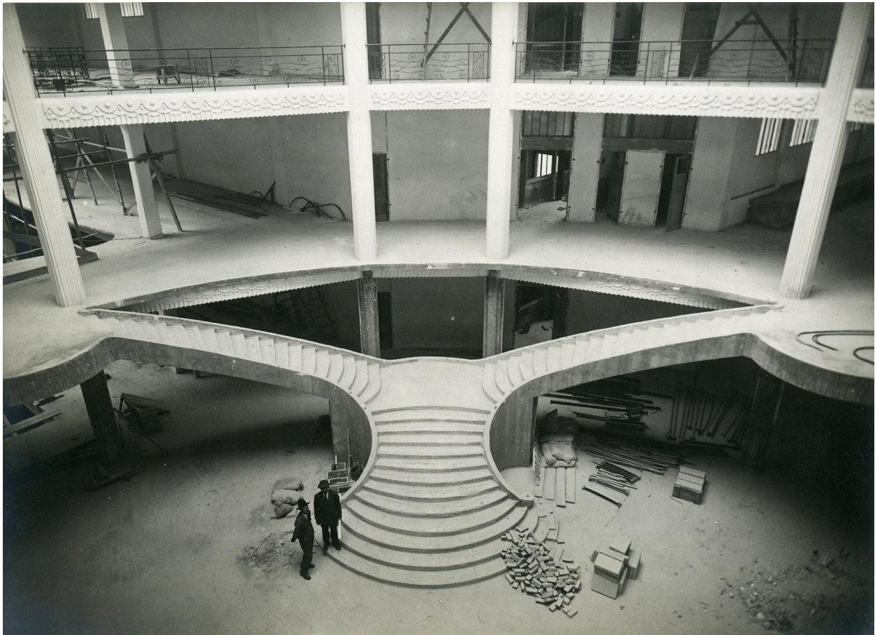
Le grand escalier de l'atrium ovale en construction, détruit en 1933 (Cité de l'Architecture et du Patrimoine ; fonds des Bétons armés Hennebique ; 3-D-370).
