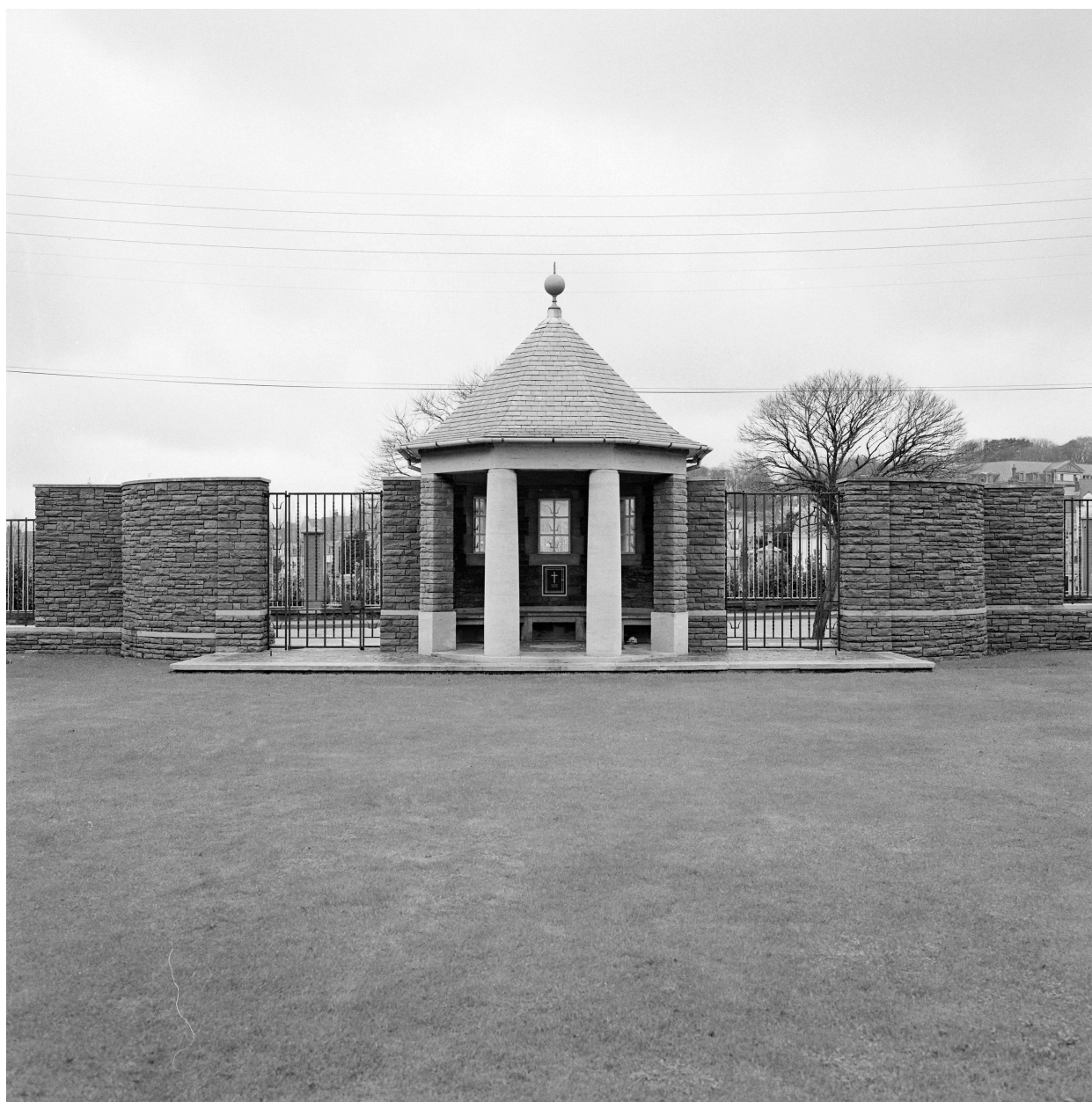
Vue du pavillon d'entrée depuis le cimetière.
