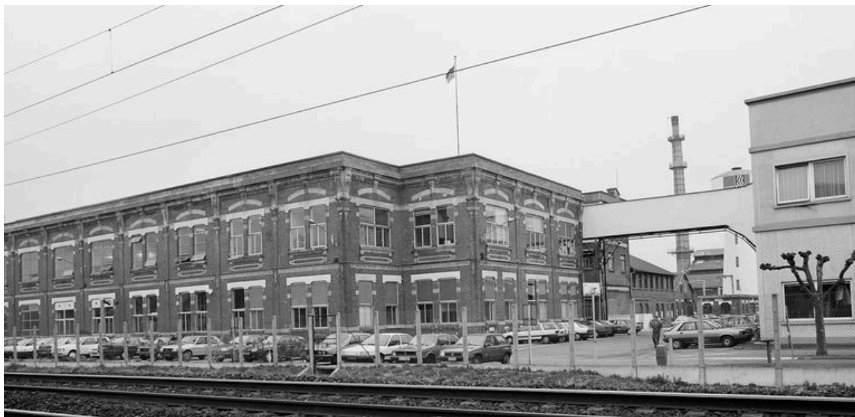
Atelier de fabrication ouest, vue partielle.
