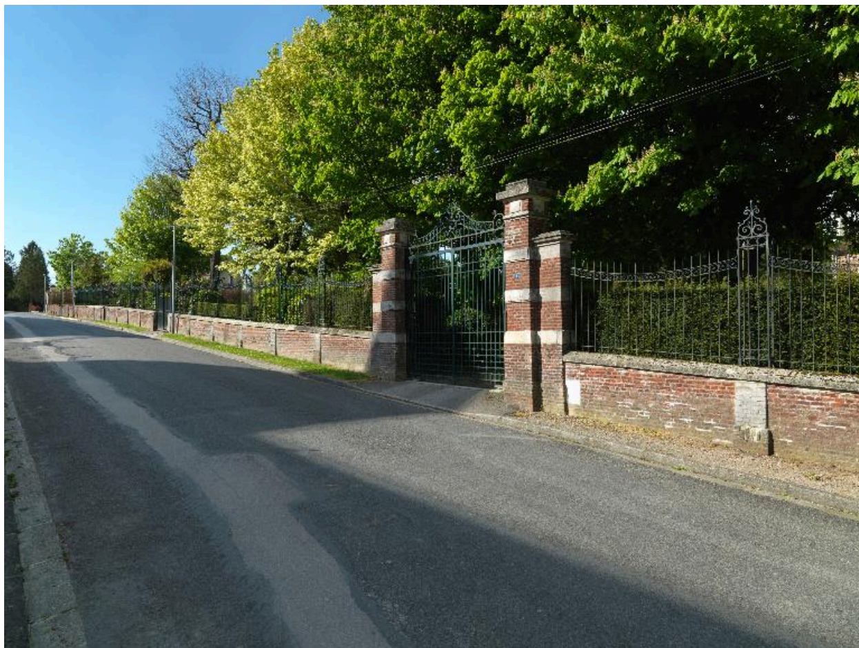
Mur de clôture de la propriété.
