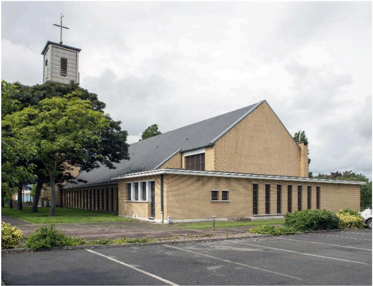
Élévation postérieure et flanc droit de l'église.
