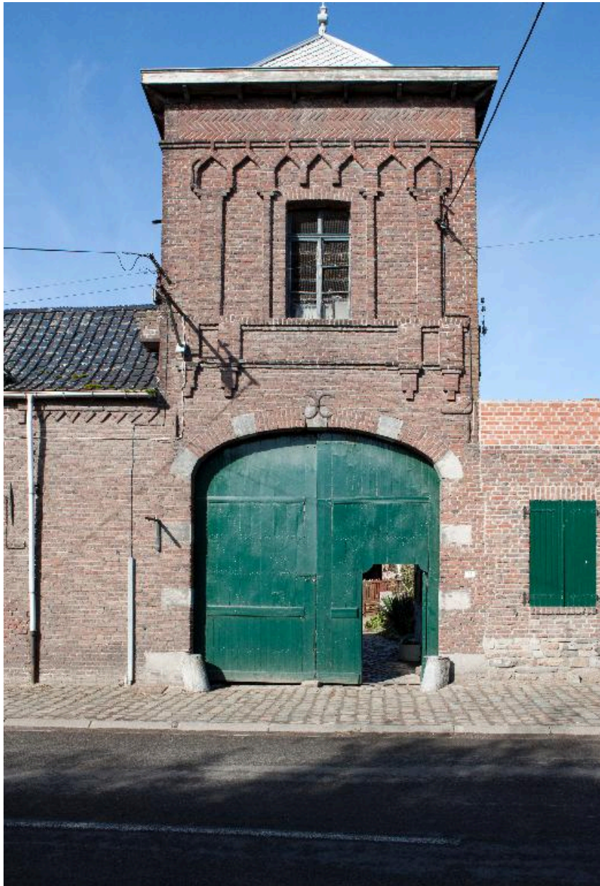
Vue générale du porche-pigeonnier de la ferme à cour fermée.
