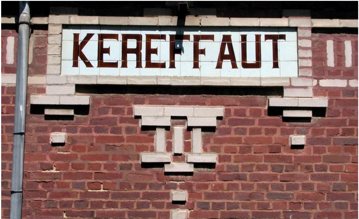
Détail de l'appellation, élévation antérieure.
