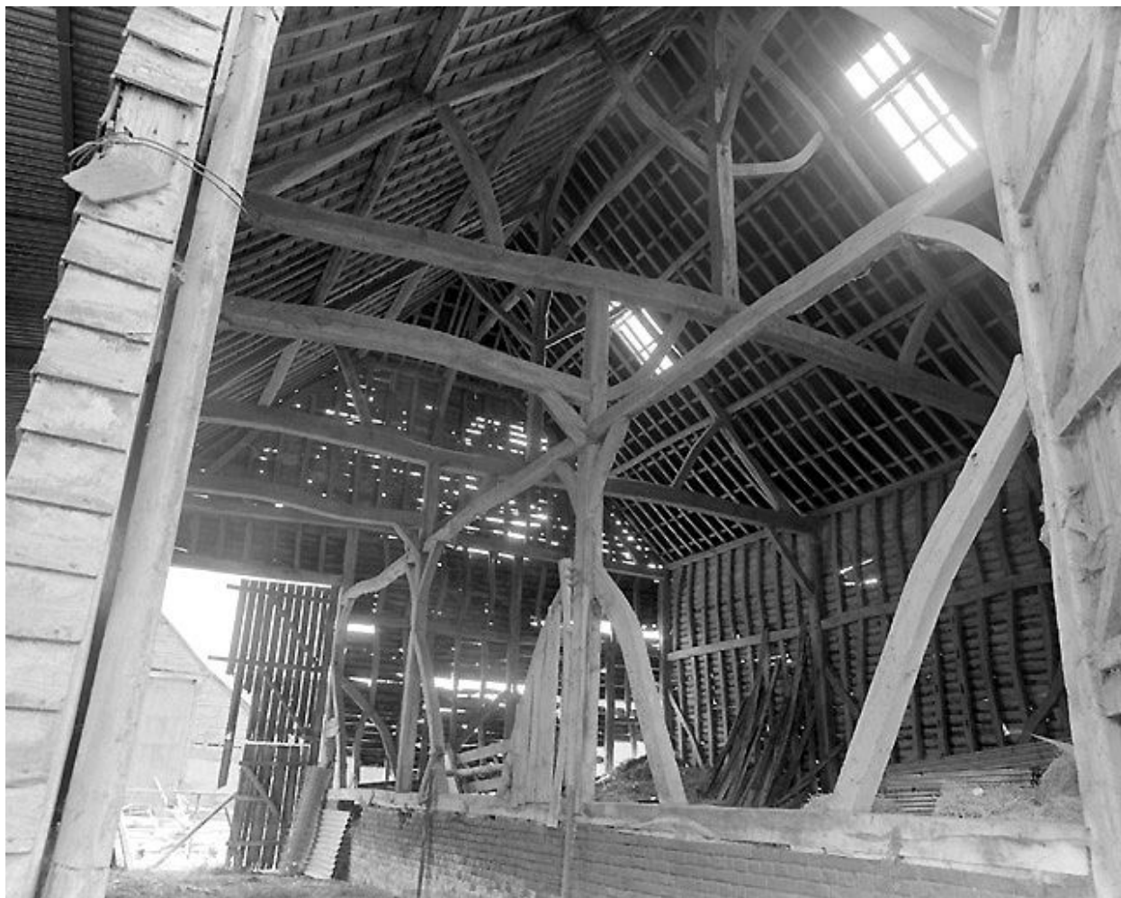
Vue intérieure de la grange.
