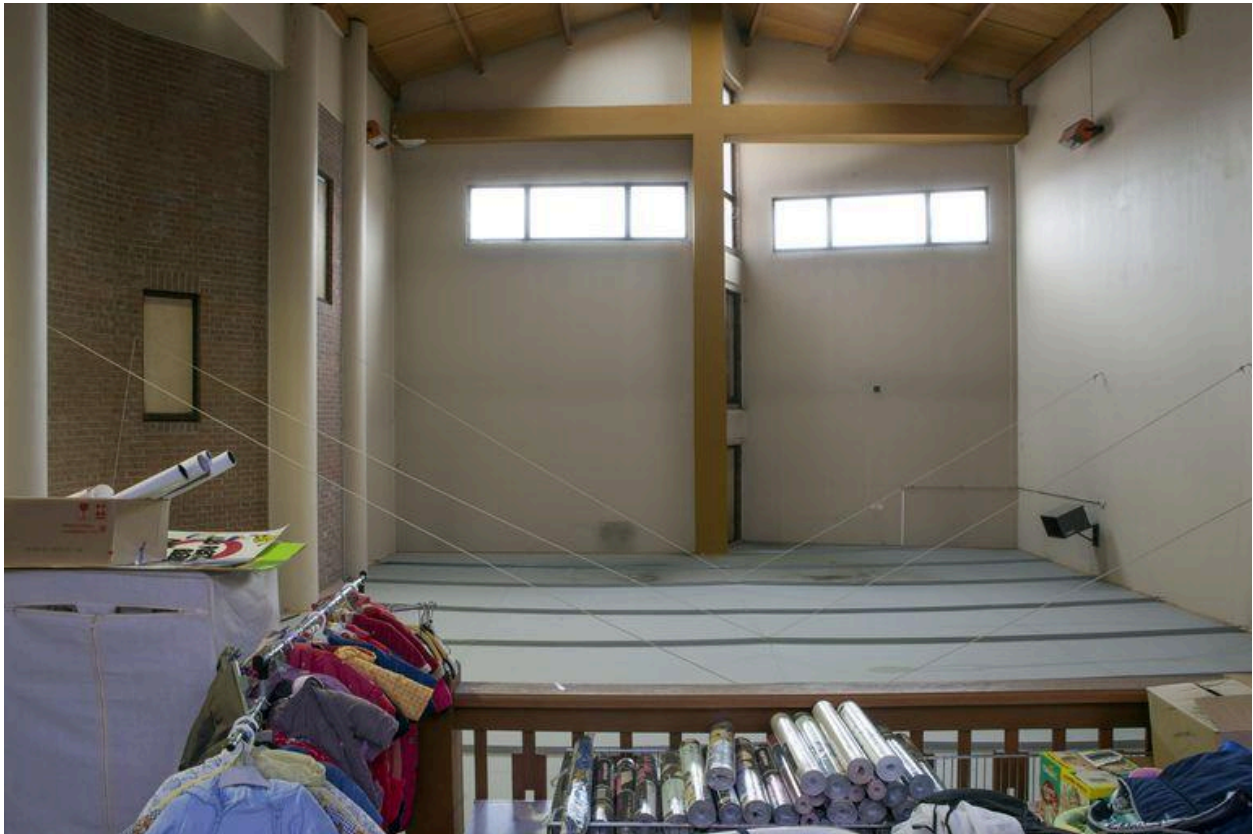
Plafond de l'église, après la création d'un étage.
