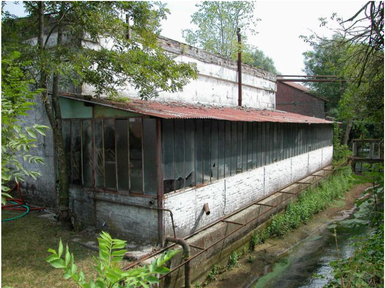
Atelier de rouissage des lins, façade nord.
