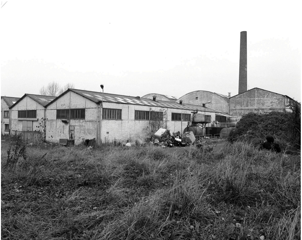
Vue générale prise vers le nord-ouest.
