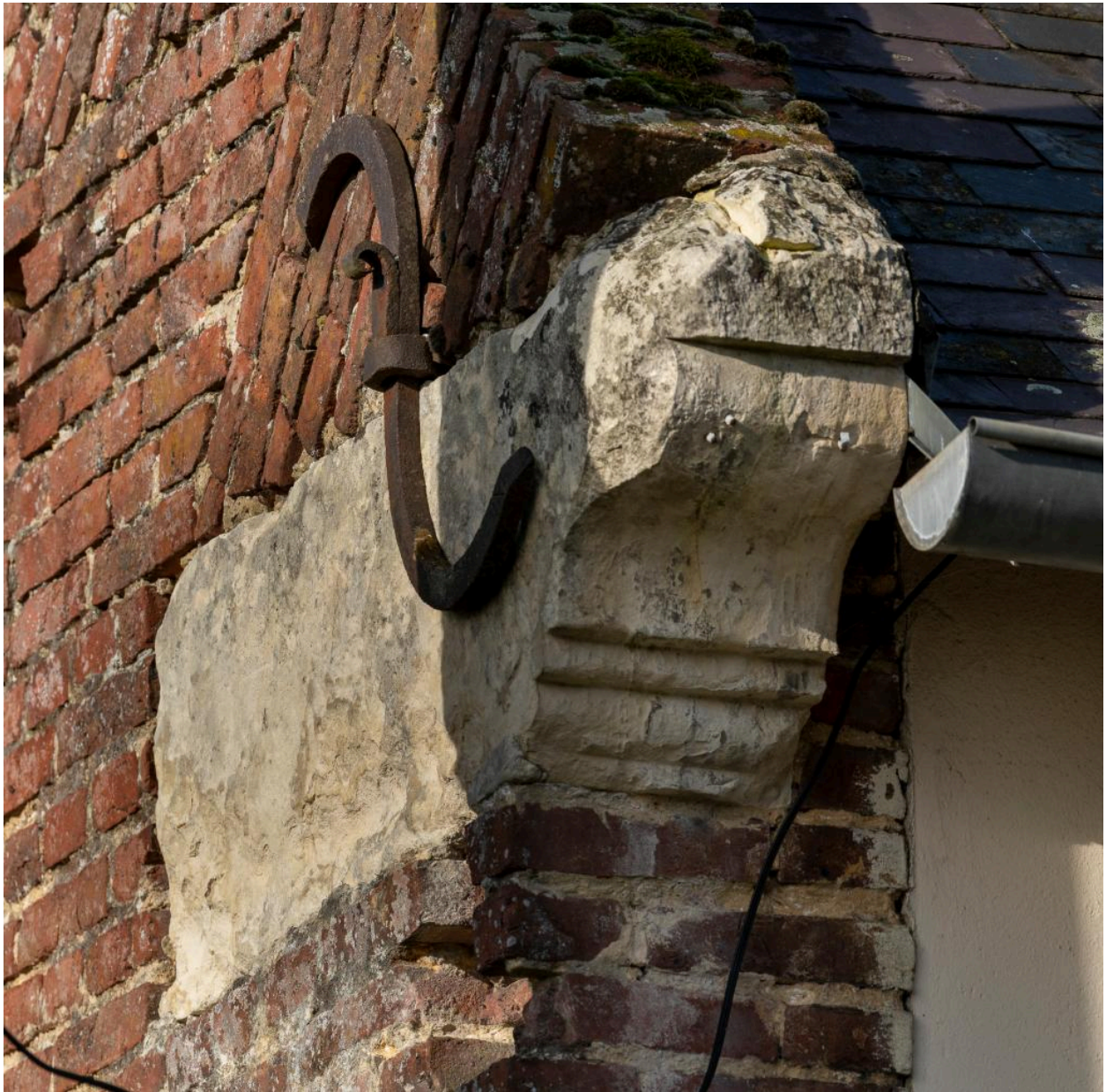
Détail du corbeau taillé en pierre, n°63 rue Principale.
