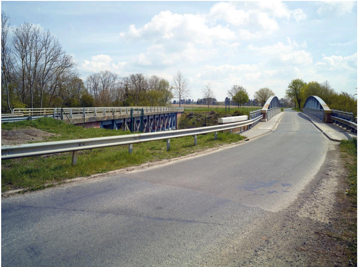
Pont routier sud. Vue prise depuis la rive ouest de l'ouvrage.
