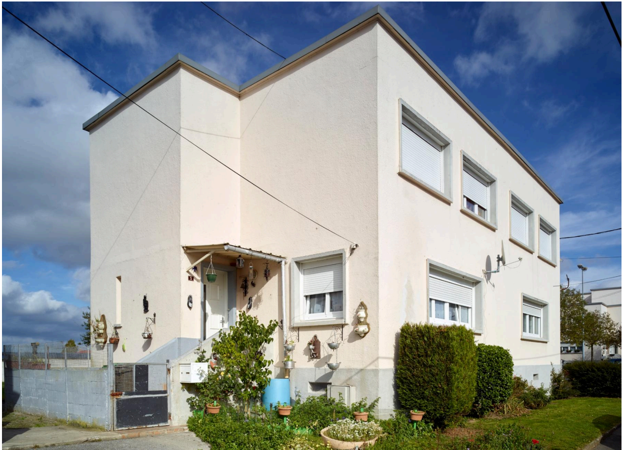
Vue des pavillons situés aux extrémités de l'opération (bloc C) prise depuis la rue.
