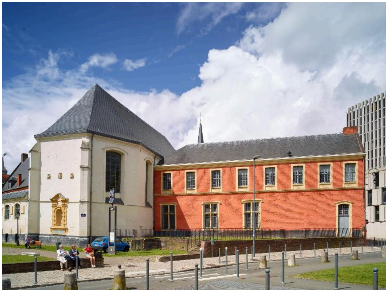
Élévation postérieure, chevet de la chapelle avec, sur la droite, le revers du bâtiment qui abritait l'ancienne salle Desmet.
