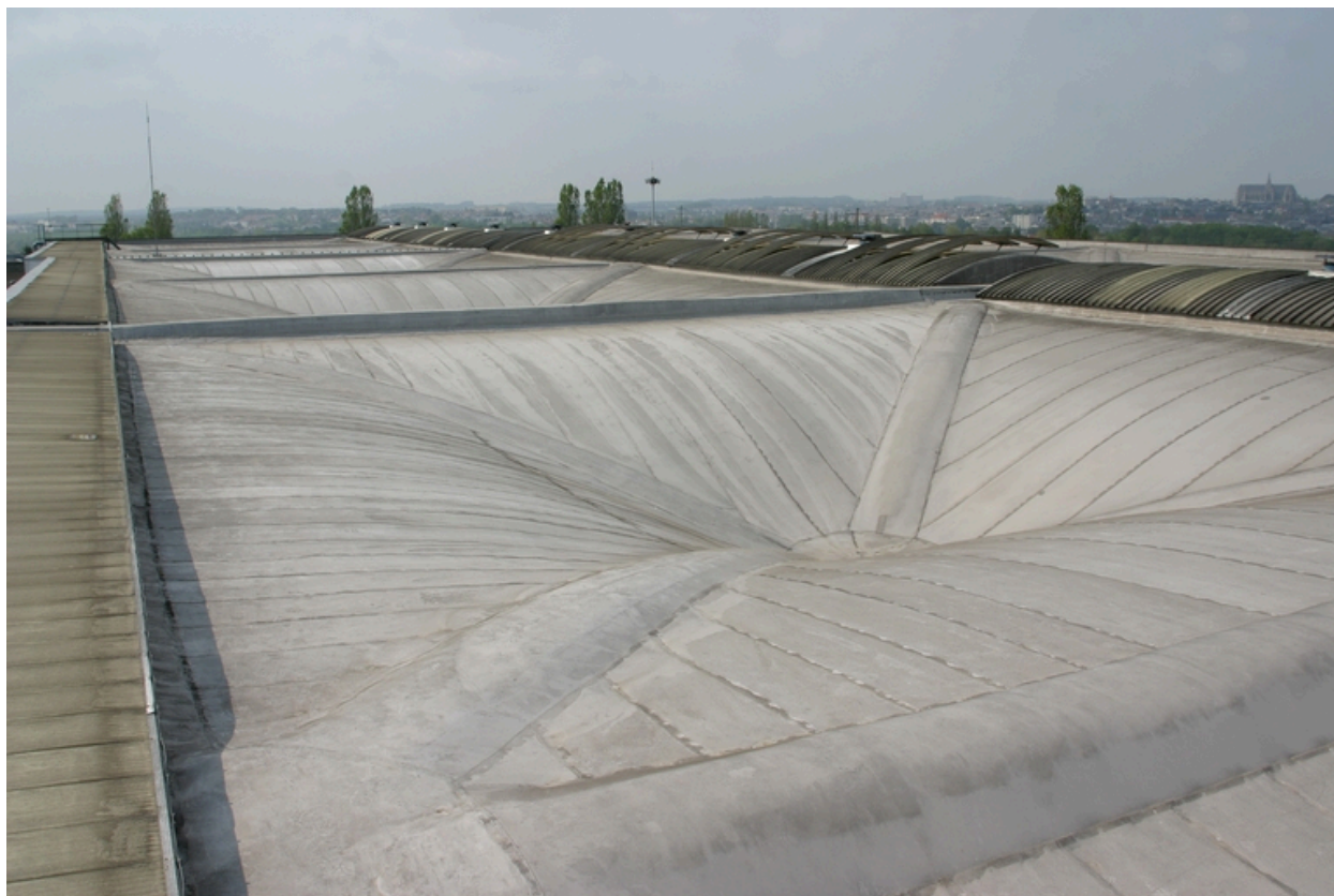
Toiture des ateliers de 1967.
