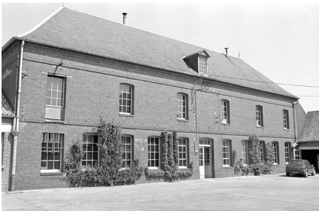
Atelier de fabrication, élévation antérieure, 1990.
