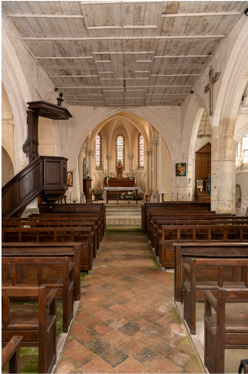
Vue intérieure vers le chœur.
