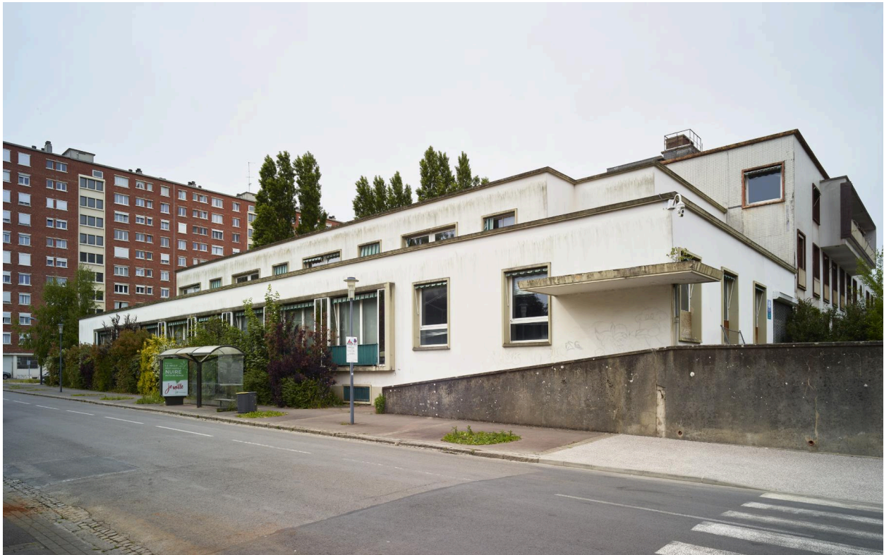
Vue de trois quarts du bâtiment de la CAF depuis le sud-est, vers l'ouest.
