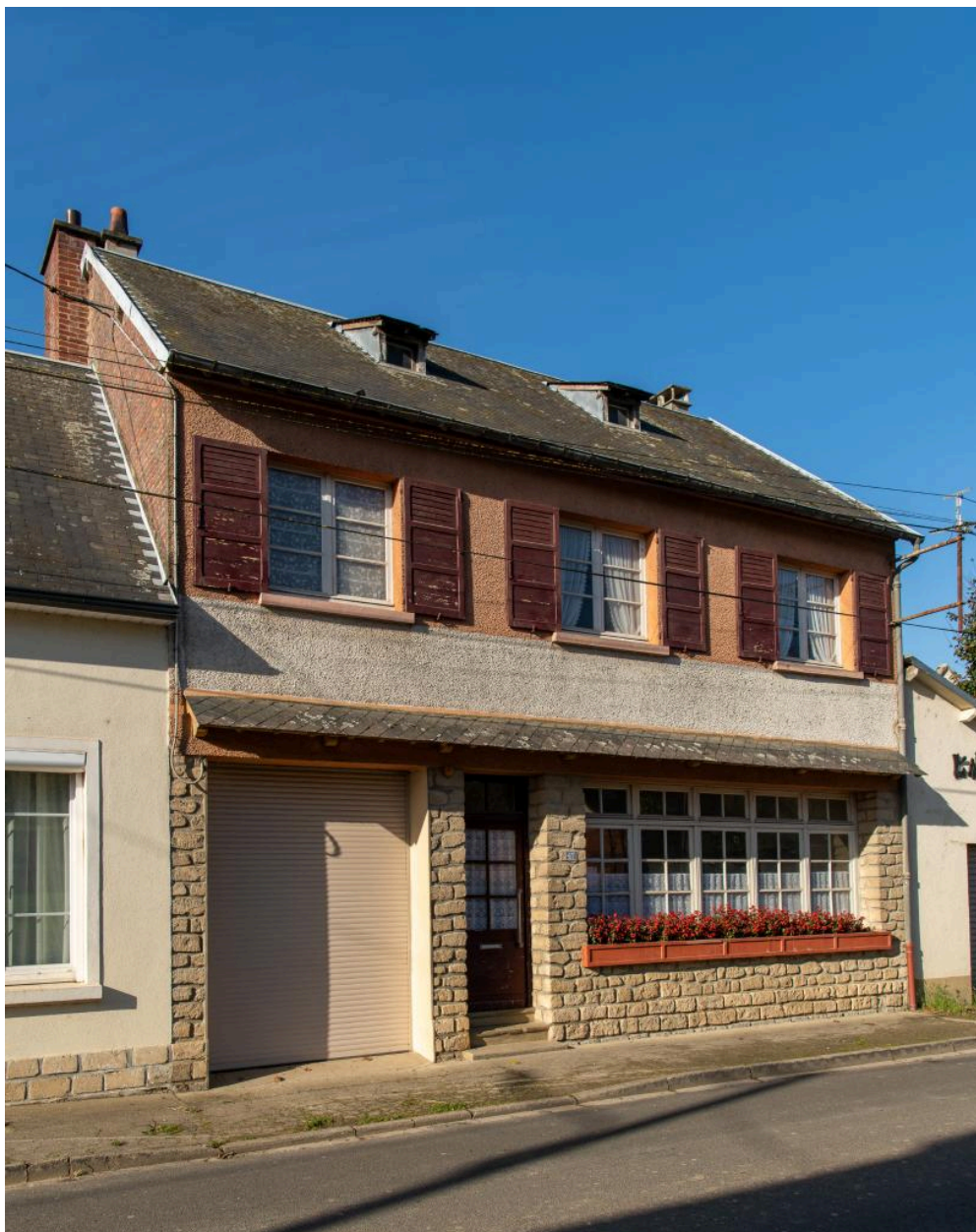
Ancienne épicerie, n°47 Grande Rue, vue depuis le sud-est.
