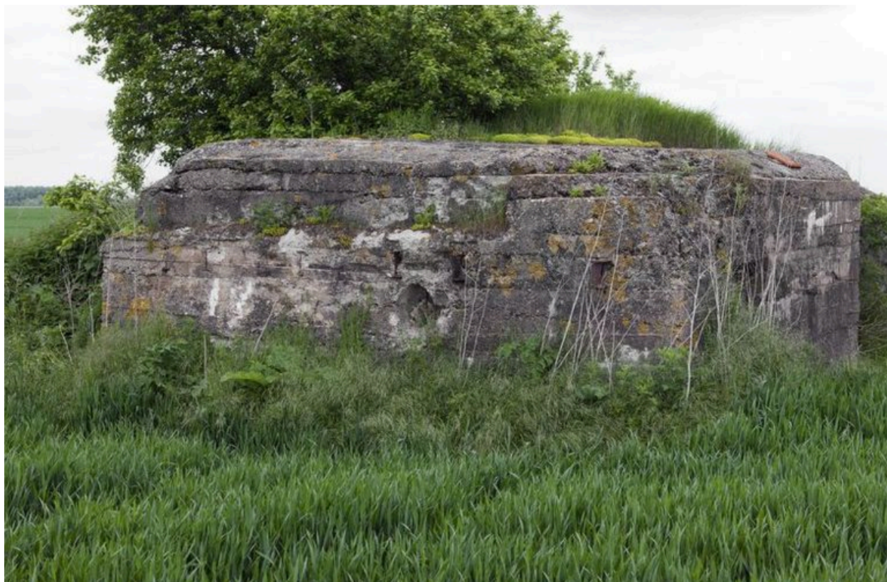
Vue latérale, vers le nord-est
