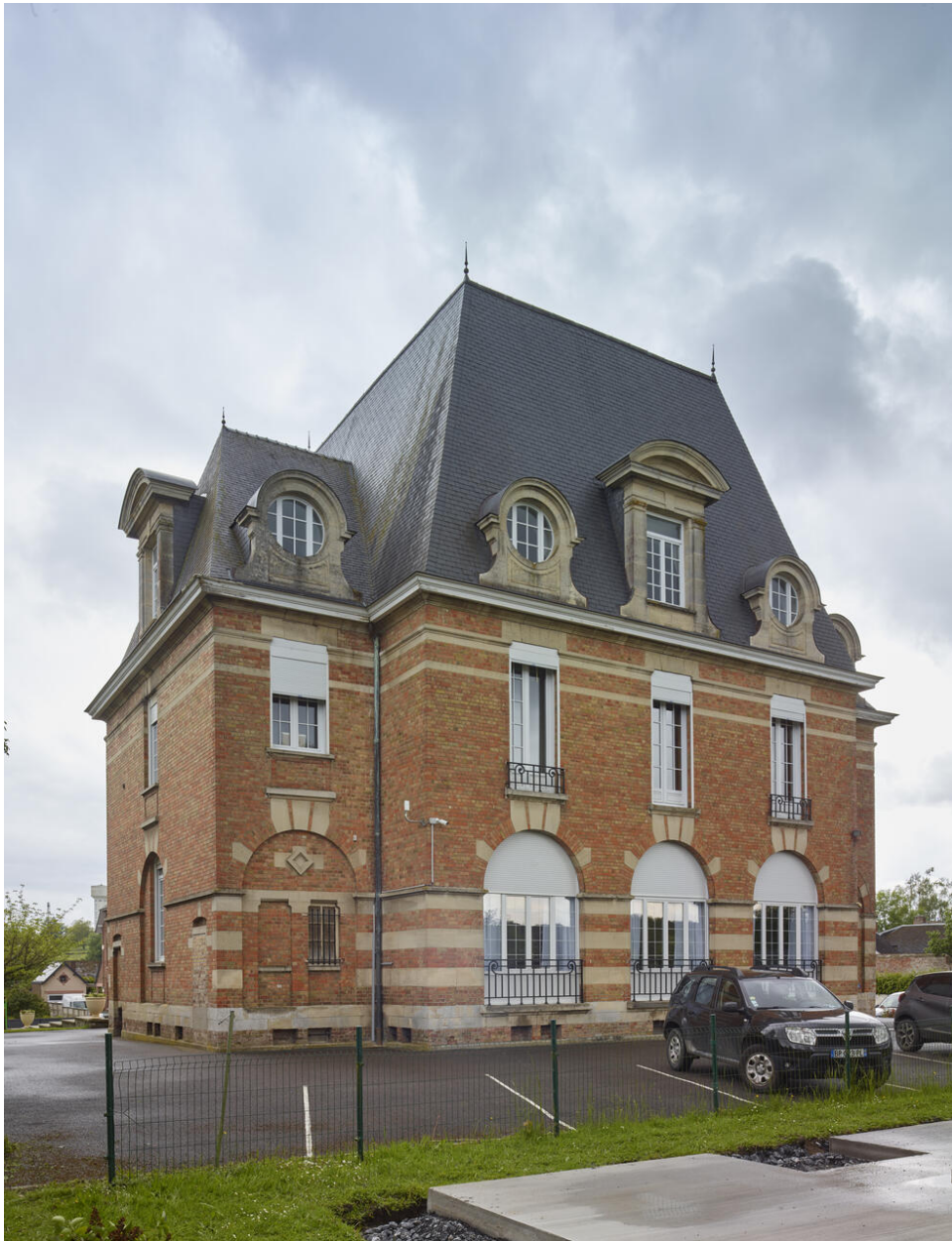
Façade postérieure, sur jardin. Vue d'ensemble de trois quarts.
