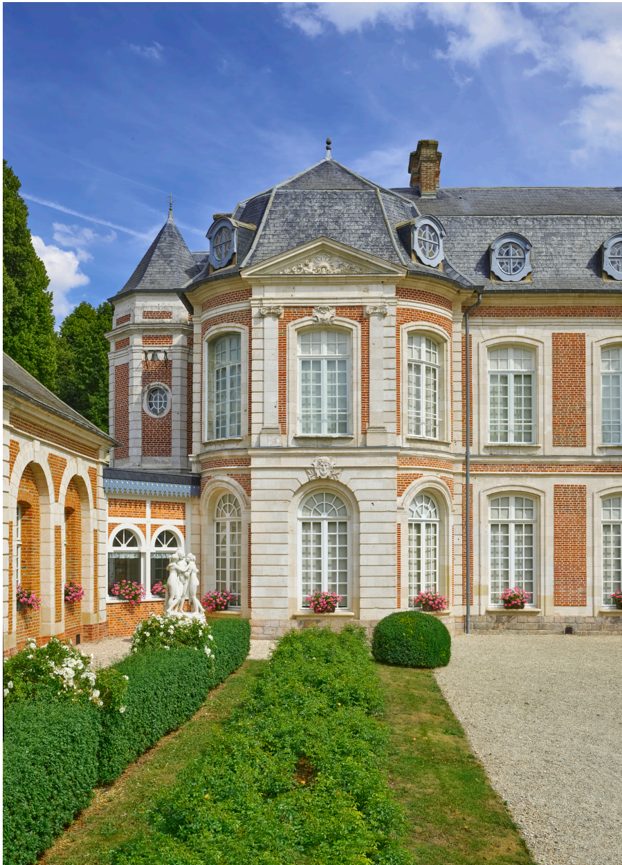
Pavillon nord, façade sur cour, vue d'ensemble.
