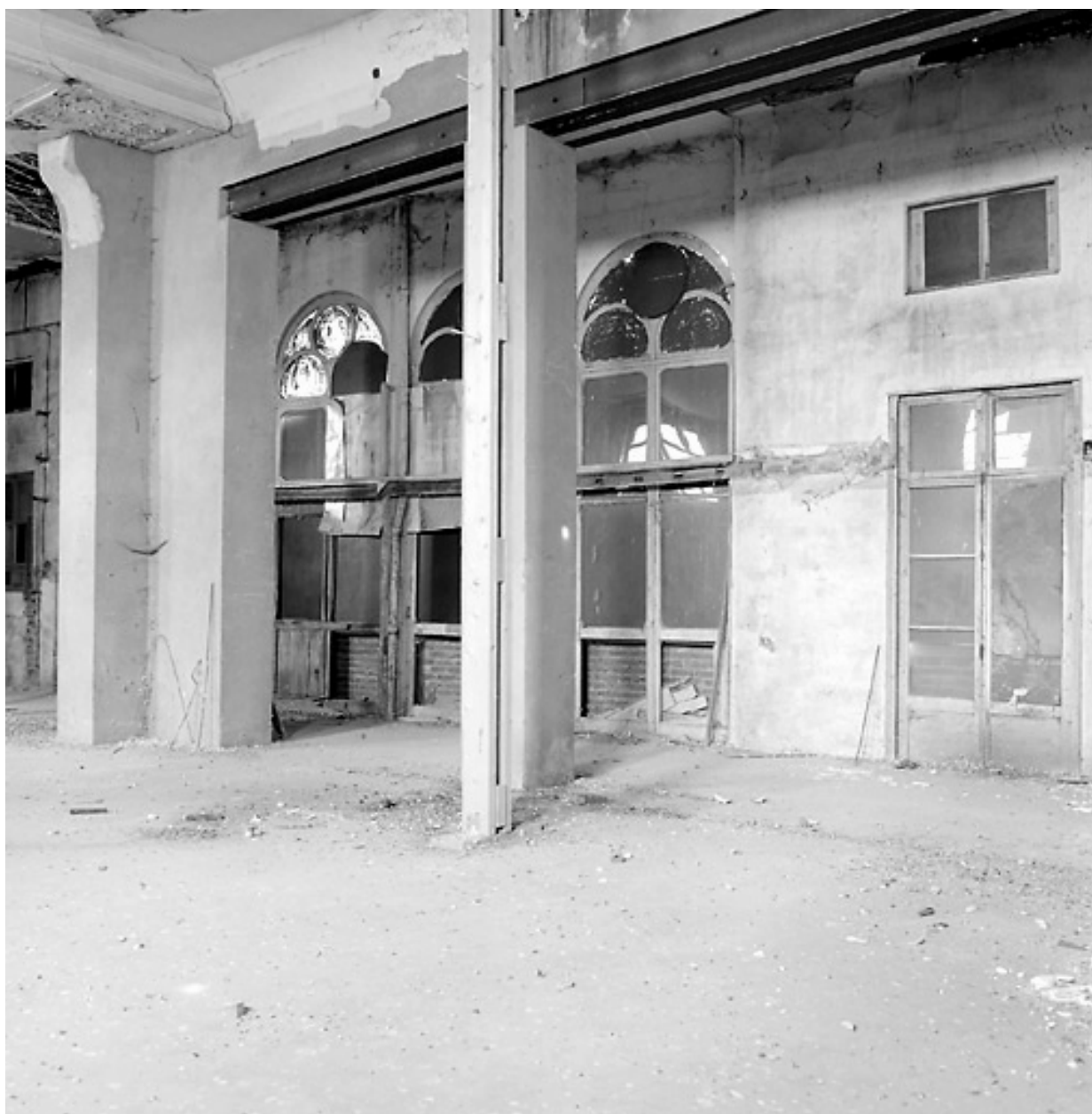
Intérieur, étage, salle de spectacle : vue vers la façade, état en 2005.
