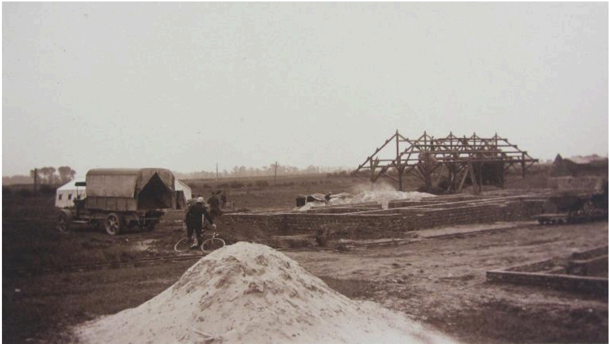
Construction du soubassement du réfectoire de la sucrerie, 11 août 1920 (AD Somme ; 10 Fi 34).
