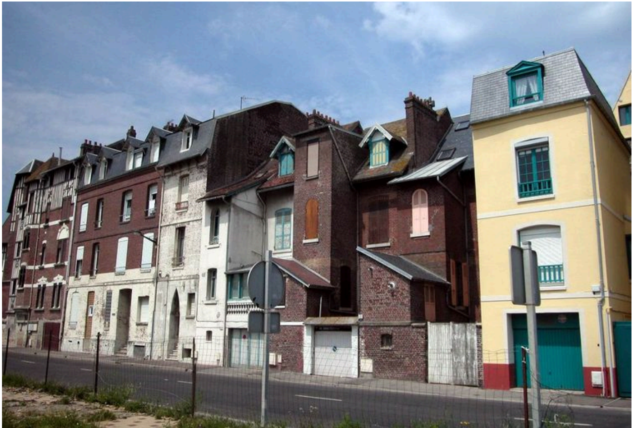
Vue d'ensemble depuis l'avenue du Maréchal-Foch, façades postérieures des maisons en front de mer.
