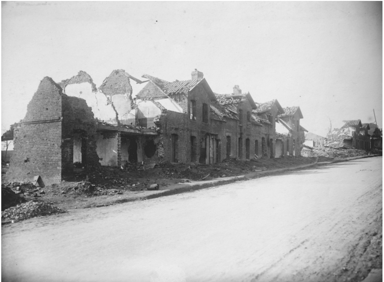
Groupe de cinq logements de type A, non restaurés après 1919 (AD Aisne).
