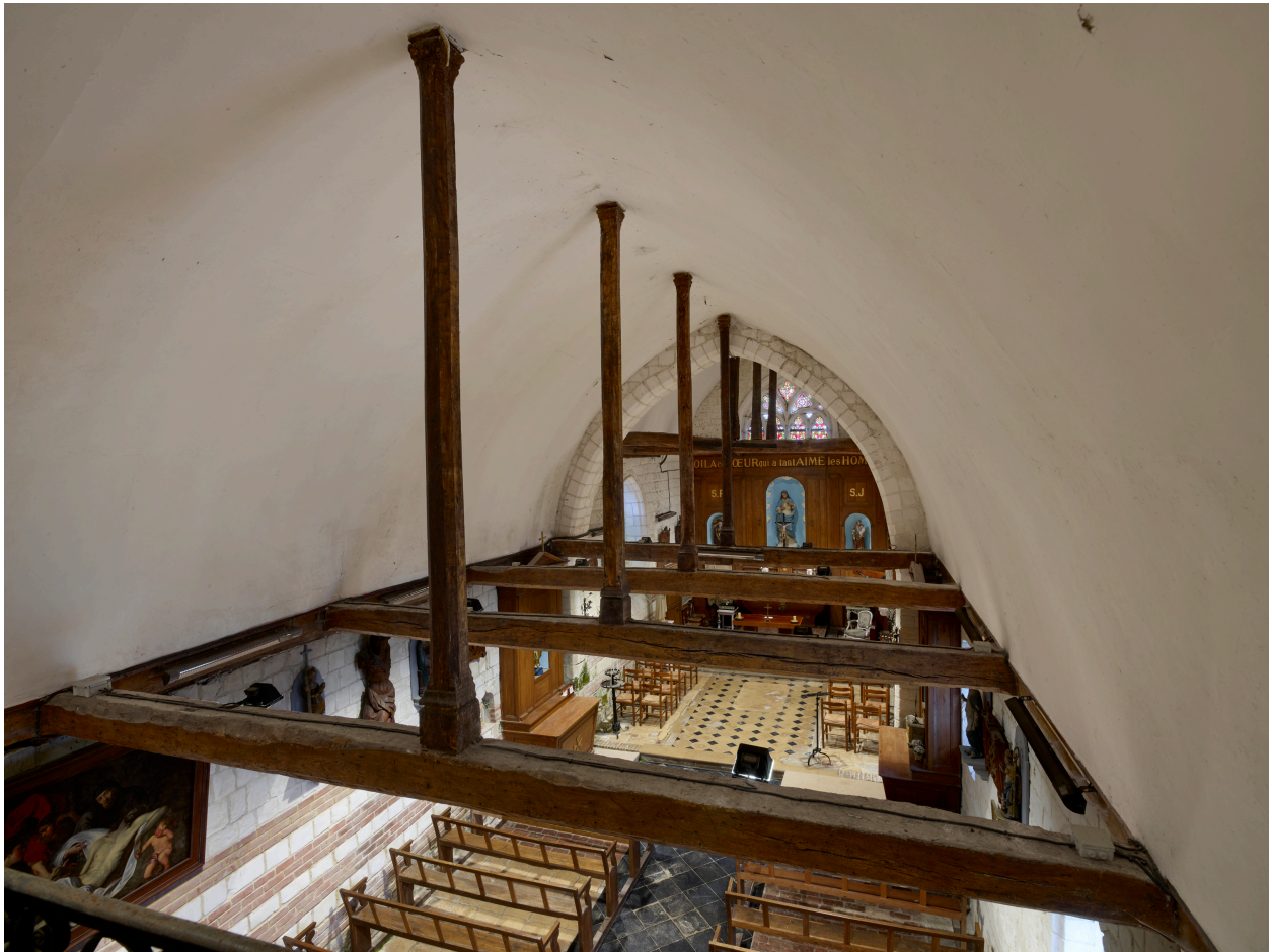
Intérieur, vue de la charpente et la fausse voûte depuis la tribune.
