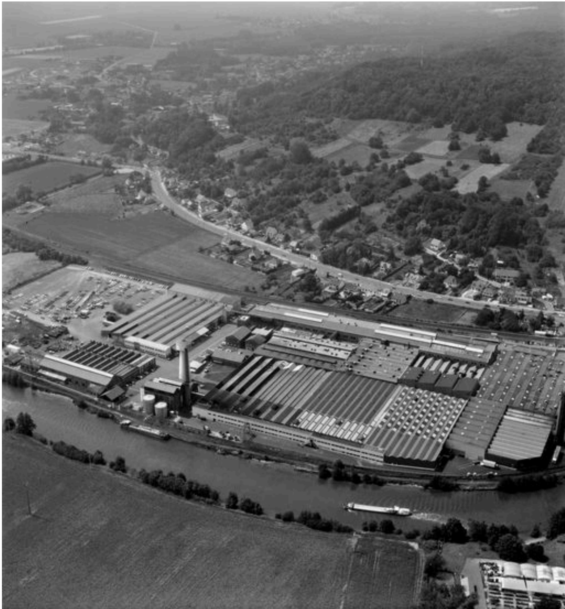
Vue aérienne générale de l'usine, en 1991.
