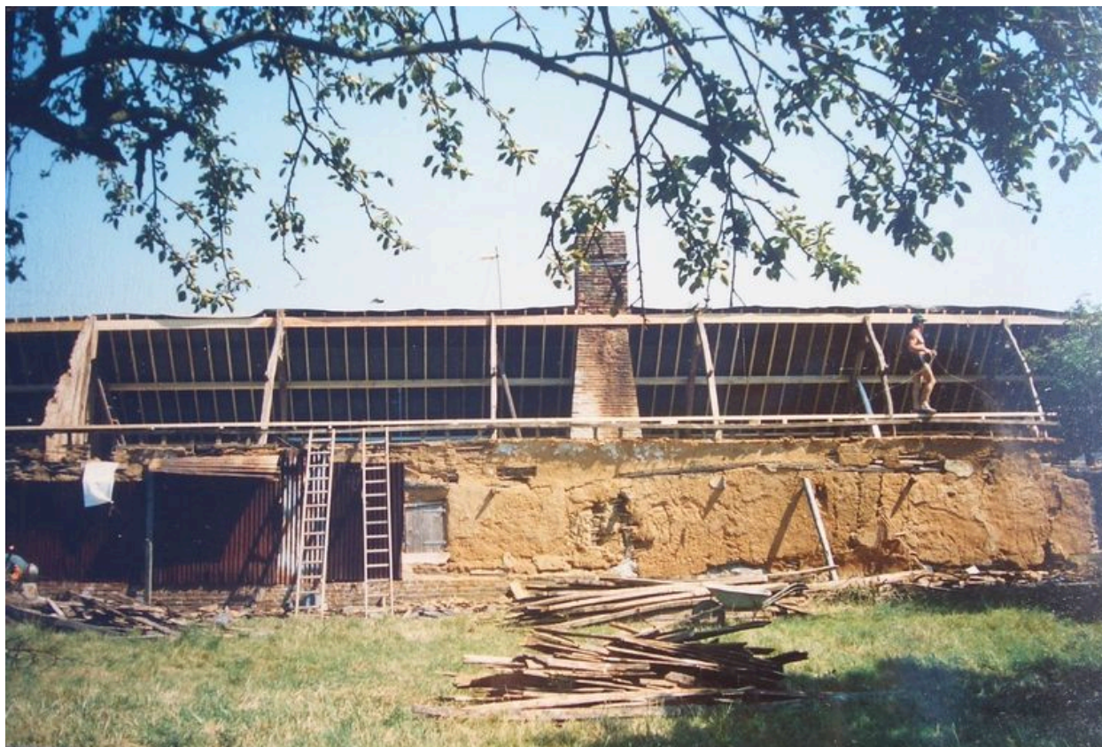
Vue postérieure du logis.
