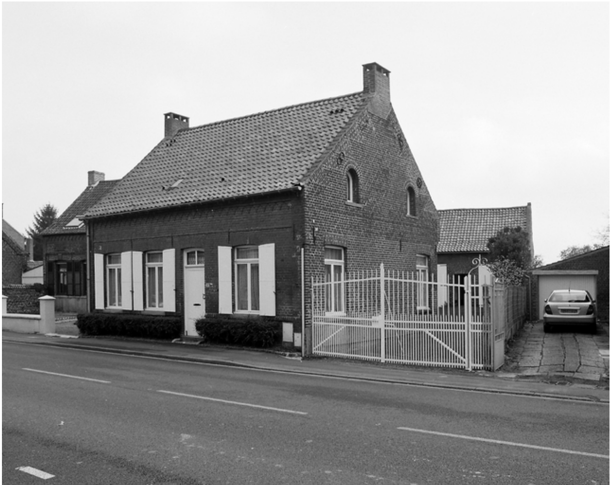
Vue générale d'une maison élémentaire.
