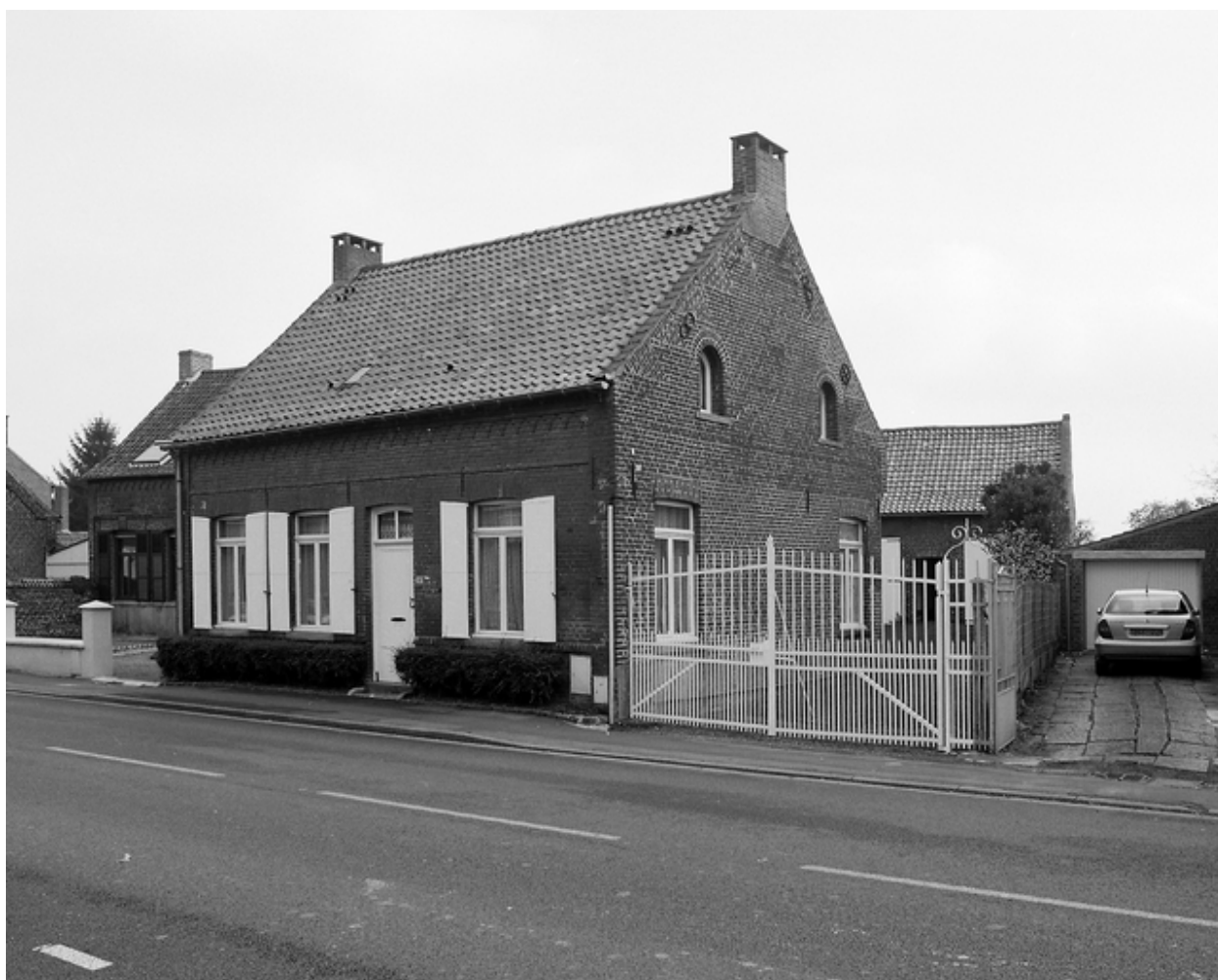
Vue générale d'une maison élémentaire.
