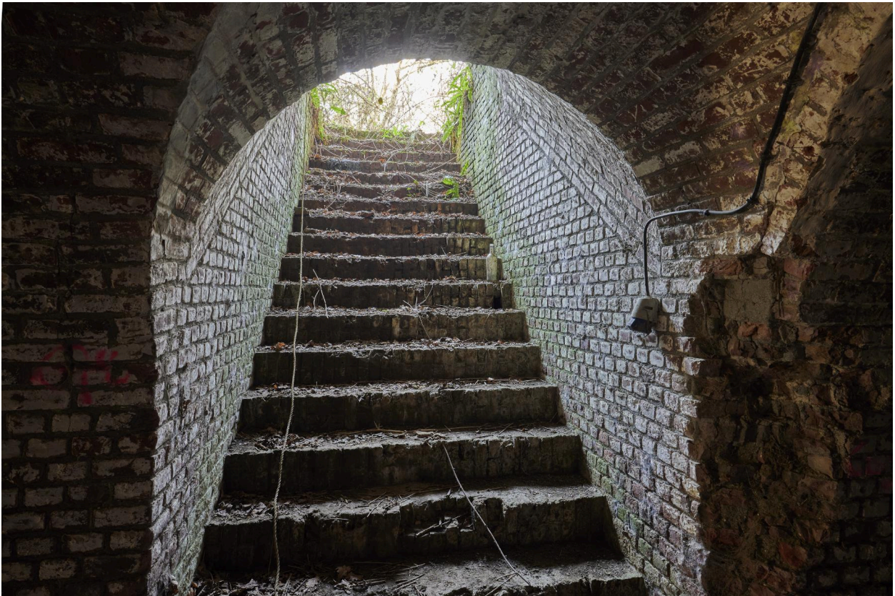
Aile est. Escalier menant du fossé à la caponnière double.
