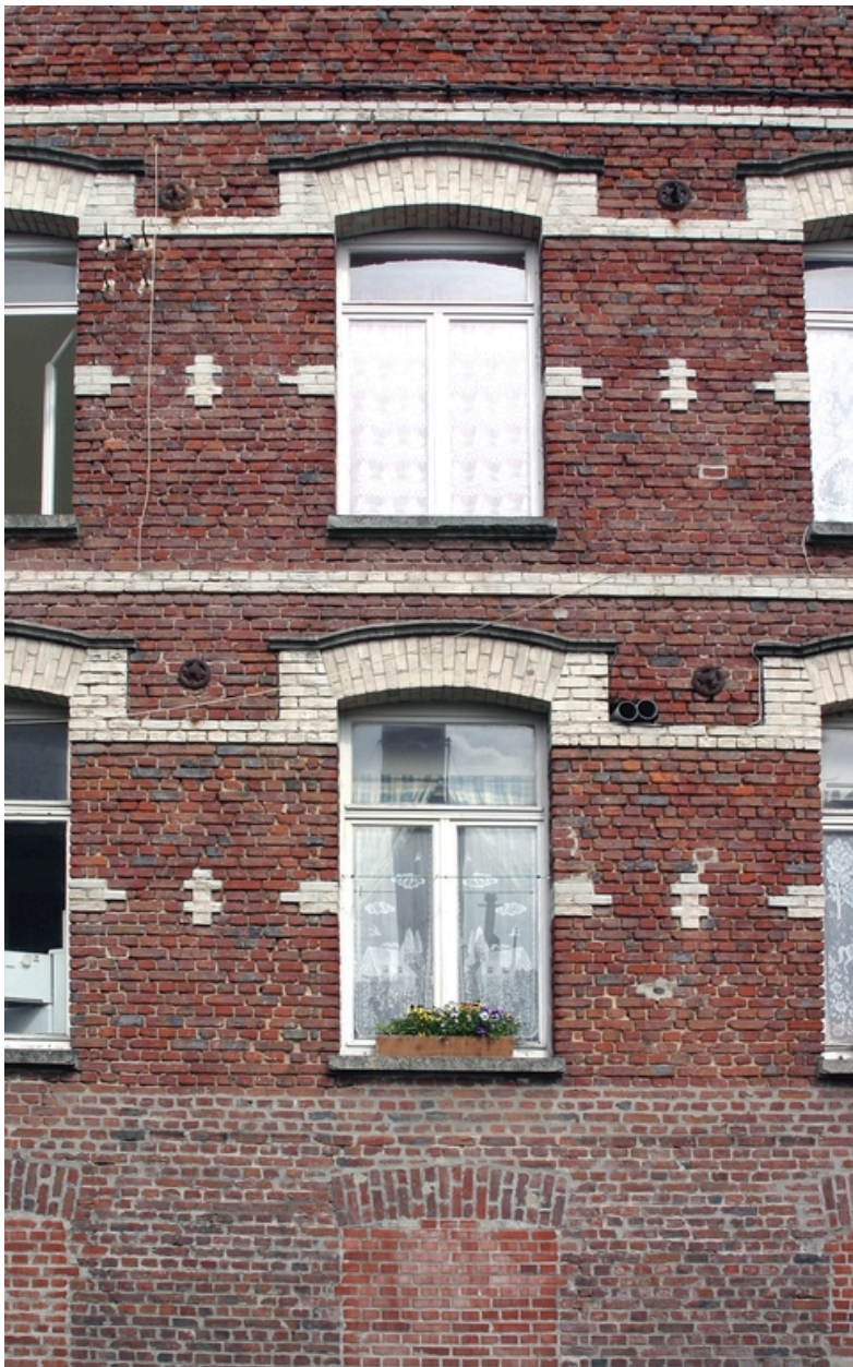
Une travée de la façade antérieure des ateliers.
